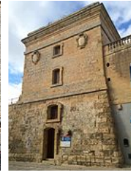
Torre dello Standardo (1725)
